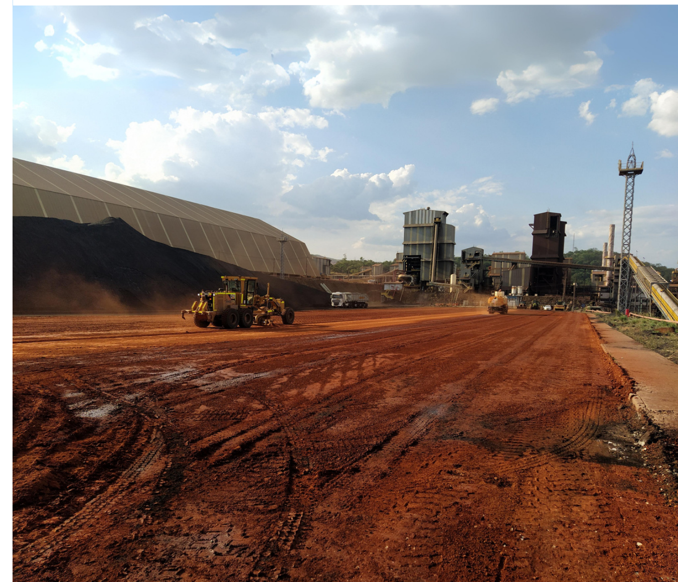
TERRAPLENAGEM DO PÁTIO DE CARVÃO ANGLO AMERICAN - BARRO ALTO - GO
